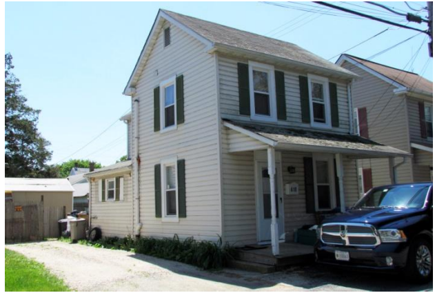
618 Linden Lane Mouldsdale Tenant House, HA-834
